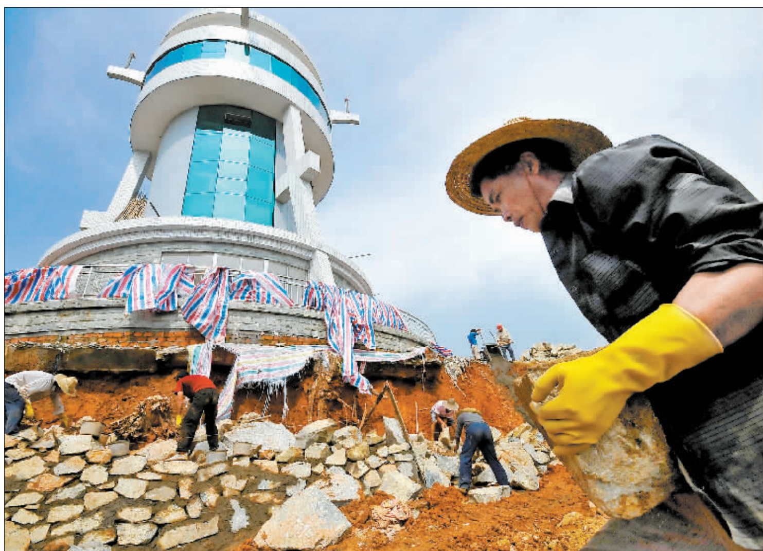
■ 昨天,施工人员在雷达塔地基处开展抢险工作。本报记者 何鑫/摄
